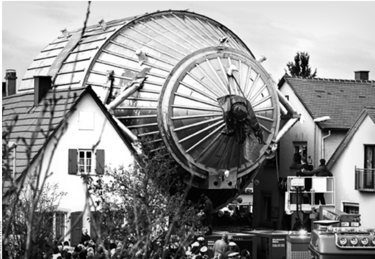
24 Meter lang, zehn Meter Durchmesser und 200 Tonnen schwer – der Vakuumtank für das Hauptspektrometer des Karlsruher Tritium-Neutrino-Experiments, kurz: KATRIN, auf dem Weg zum KIT (Leopoldshafen, November 2006)
