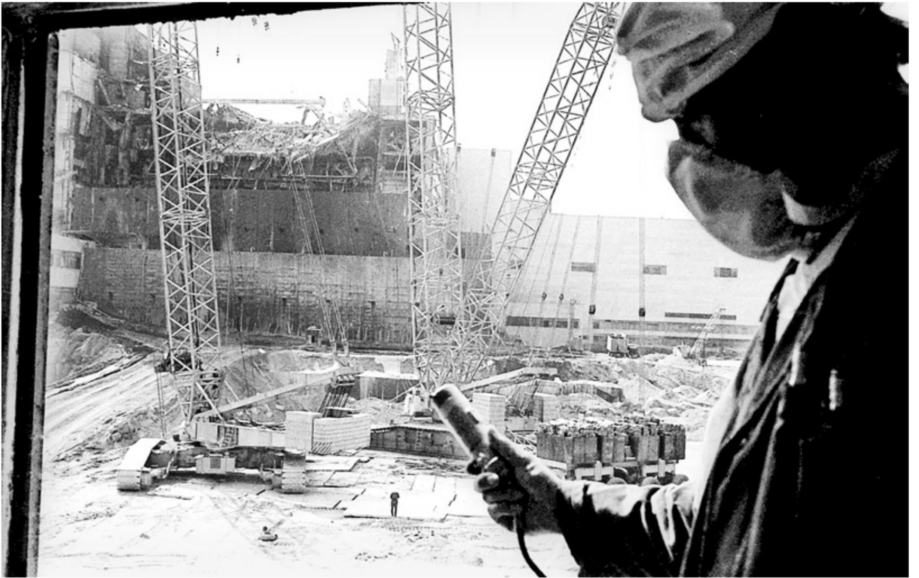
Bei der Übung einer Schnellabschaltung bei gleichzeitigem Kühlmittelverlust geriet am 25. April 1986 der Reaktor 4 im AKW Tschernobyl außer Kontrolle. Zusätzlich machte das Personal Bedienungsfehler – es kam zur befürchteten Kernschmelze (Aufnahme vom 12.5.1986)
