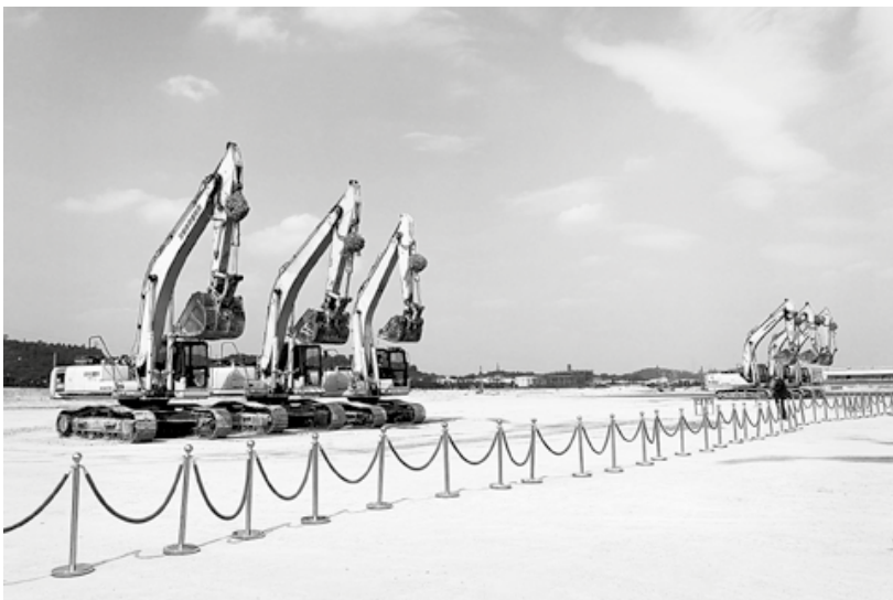
Weiter geht's: Baustelle für neue Flatscreen-Fertigungsanlage des Konzernriesen Foxconn in Guangzhou am 1. März
