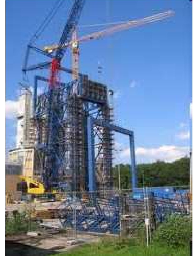
Bau einer Schutzhülle um den AVR-Reaktor (2006)
