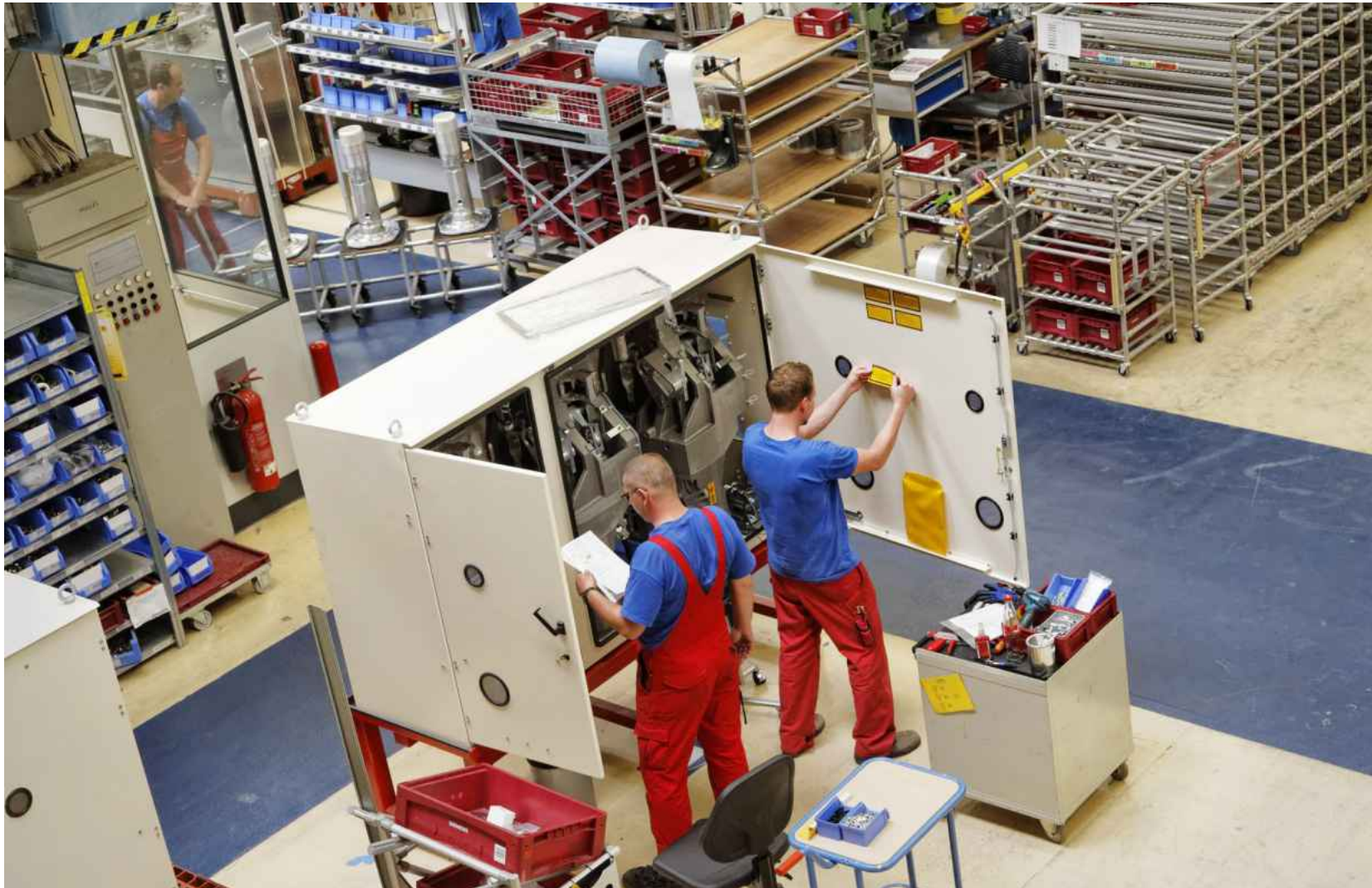
Arbeiter im Schaltwerk von Siemens
