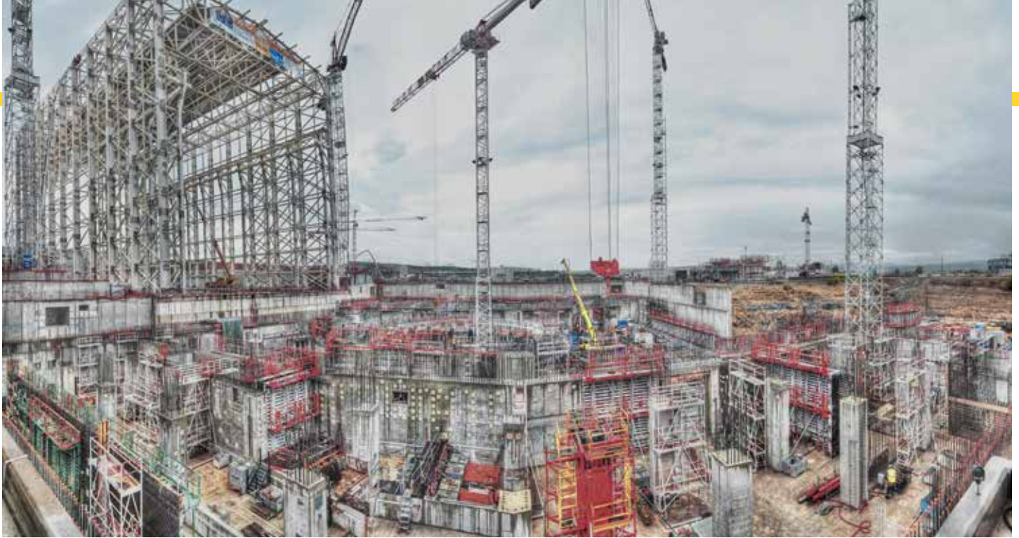
Baustelle des Fusionsreaktors ITER im südfranzösischen Cadarache
